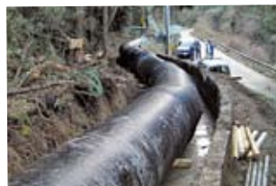
▲上水道管(誘導管)
