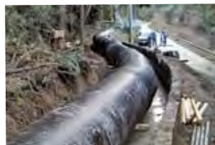
▲上水道管(誘導管)
