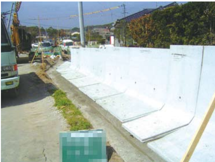
L型擁壁の基礎地盤補強に採用されました。農耕地に隣接しているため、コンクリートによる地盤改良が行えず、周囲の環境に影響を与えないジオグリッドを用いた「マットレス工法」が採用になりました。
