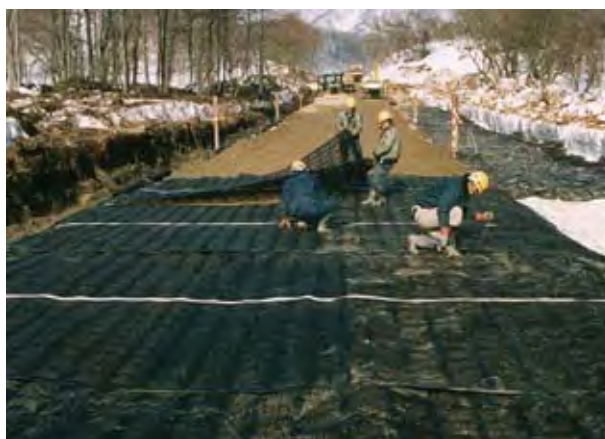
軟弱地盤において不同沈下を防ぐ
