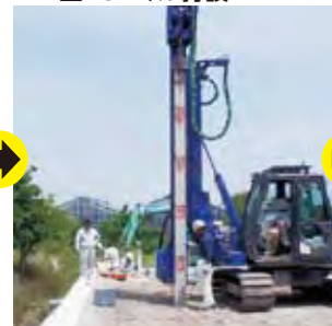
2: H型PCパイプ打設
