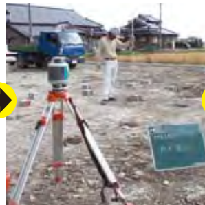
3: 杭天レベル確認
