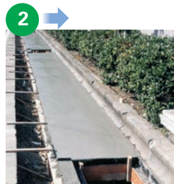
コンクリート打設
