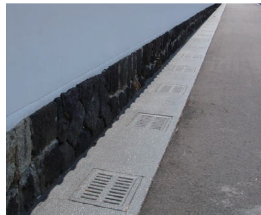
施工事例(黒御影調塗装仕上げ)
