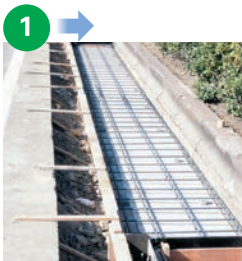
KCフォームの上に配筋した状態
