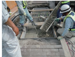
⑤生コン打設
