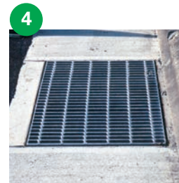
グレーチング設置
