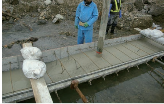
水中コンクリート打設
