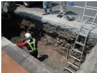
①掘削状況
