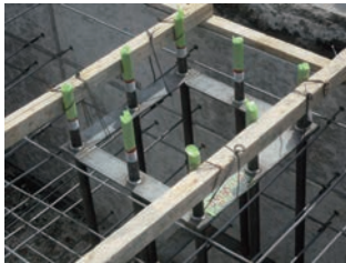
④アンカー筋設置
