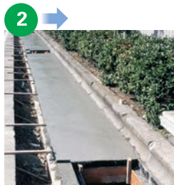
コンクリート打設
