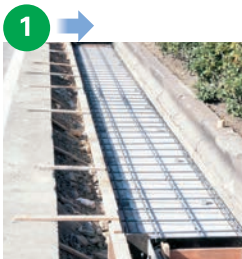
KCフォームの上に配筋した状態
