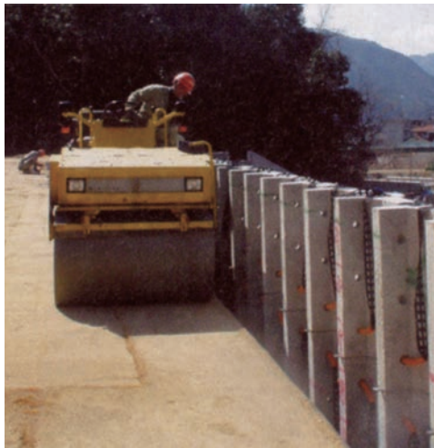
【碎石型枠変形前】 重機によって締固める前の 壁面近傍部
