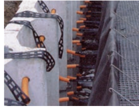
【碎石型枠変形前】 重機によって締固める前の 壁面近傍部
