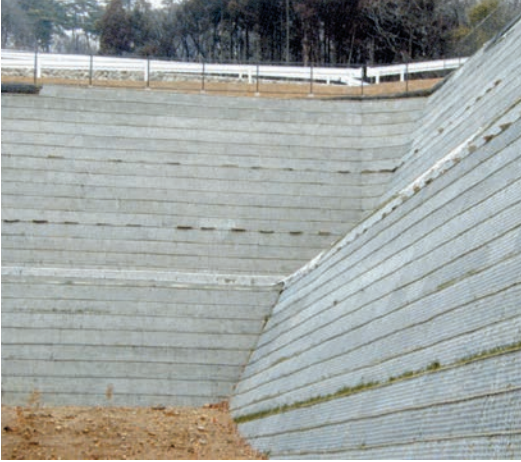
●巻込み無し工法(ユニットキャップ工法)
