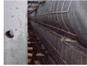
【碎石型枠変形後】 十分な締固めによって変形した 碎石型枠
