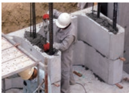
⑤ 縦貫コンクリート打設
