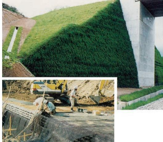
●巻込み無し工法(ユニットキャップ工法) 宅地造成盛土工
