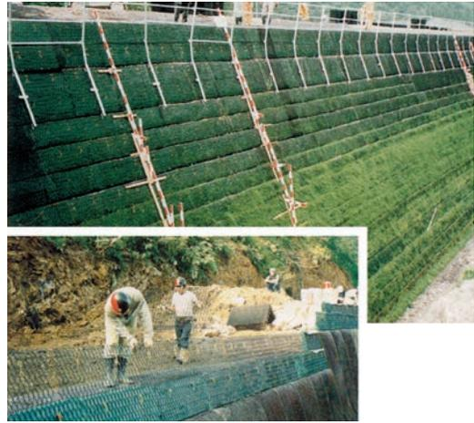
●巻込み無し工法(ユニットキャップ工法) 道路盛土工
