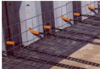
■砕石型枠 壁面材と盛土を分離させることで、盛土への十分な転圧が可能となり、壁面に影響を与えることのない二重壁構造を構築することができます。
