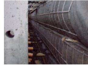
【砕石型枠変形後】 十分な締固めによって変形した 砕石型枠
