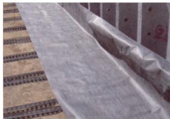
■拘束シート 砕石型枠のすき間から盛土材が変形吸収層へ吸い出されないように砕石型枠に取り付けます。また、砕石型枠付近の土を拘束し、盛土の安定に重要な役割を果たします。
