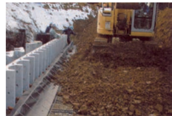
■盛土材 面状の補強材で、あるアダムと水平排水材を使用することにより、適用できる盛土材の土質範囲が広がります。
