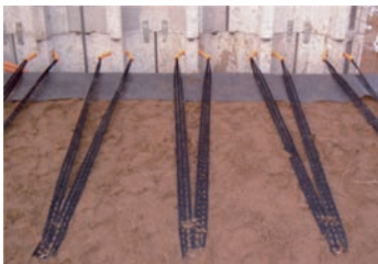
■引抜け防止材(グリッドベルト) 引抜け防止材「グリッドベルト」により、壁面材と盛土を一体化しています。壁面材に8本のグリッドベルトを設置するため、壁面材と連結部に作用する荷重が分散され、より安定性が向上します。
