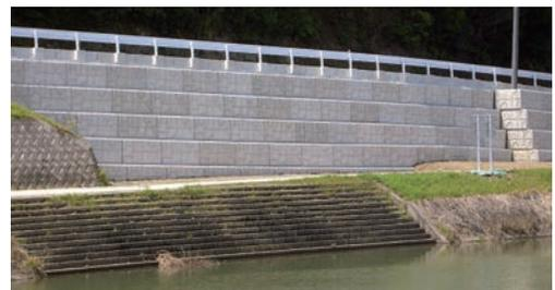
箱型擁壁は、箱体と壁体材(単粒度碎石)で構成されており、特別な排水装置を備えなくても極めて排水性が高いのが特長です。湖沼、ダム湖などの水際・水中部擁壁として使用する場合は、通水性が良いため、単粒度碎石による礫間水質浄化効果があります。さらに水際生物の生棲にとっては、小段部の自然植生・陸上への始動がしやすいなど、比較的大きな生態系保全空間をえられます。
