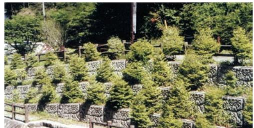
箱体前面の小段は、グリーンカップを設置することで植栽が可能、多様な自然環境や景観に配慮した擁壁を構築することができます。緑化の方法には、グリーンカップ内に客土して人為的に植生する場合と、小段部に土嚢を配置したり客土を撒きだして現地の植種を自然に回復させる自然植生とがあります。
