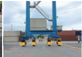
南港コンテナヤード (トランスファークレーン走行箇所)
