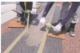
4. マスキングテープ(上部)を除去養生
