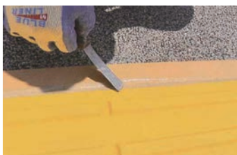
7. 点字タイル端部のテーパ処理
