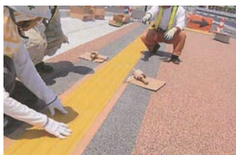
8. 通り(直線性)の確認
