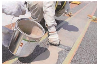
3. 専用接着剤の塗布・下塗り(シゴキ)
