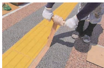
9. マスキングテープの除去 マスキングテープを取り除きます。接着剤が舗装面に垂れないように注意して巻き取ってください。
