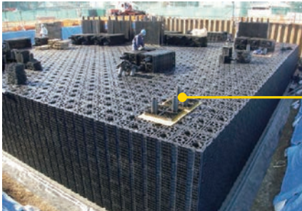
継手を使わない千鳥配置構造のため、地震時に発生するせん断変形に強い
