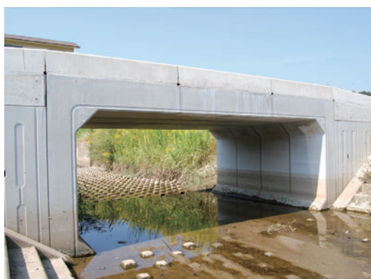
▼アンダーパス非開削施工R&C工法1
