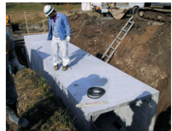
6. カップリング付ボックスを終端に据付
