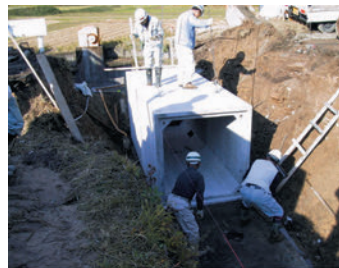
5. 普通型を据付
