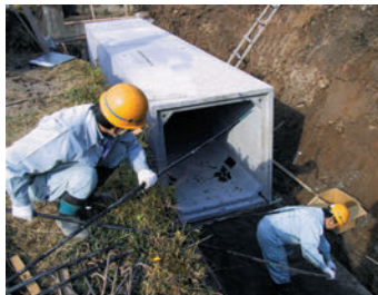
7. PC鋼より線を4穴に通す
