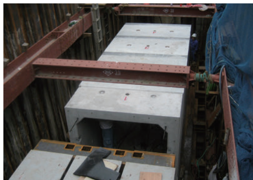
▼アンダーパス非開削施工R&C工法1
