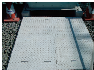
■設計条件(人荷重) 群集荷重:q=5kN/m 2
