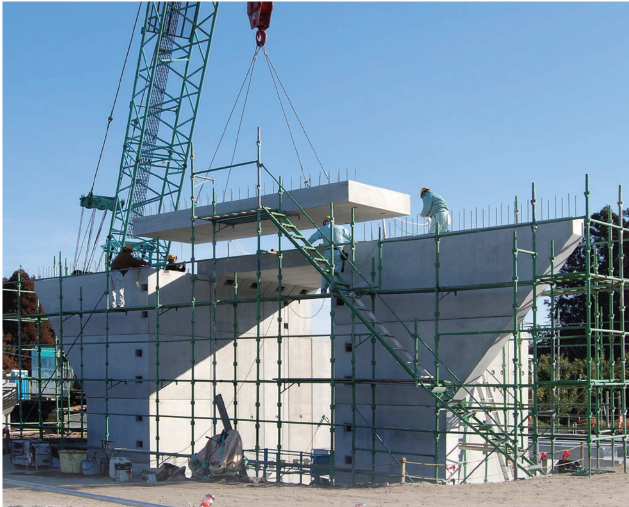
■3段目ブロック設置
