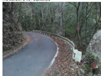
湯島崩野線:施工前
