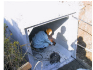
12. 最後のカップリング付ボックスの部分でPC鋼より線を定着した後、切断
