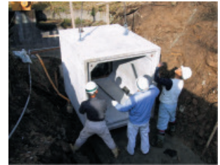
4. カップリング付ボックスを始めに据付
