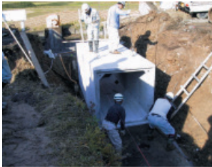
5. 普通型を据付
