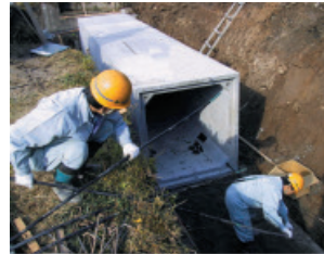
7. PC鋼より線を4穴に通す
