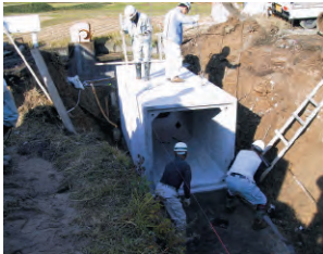
5. 普通型を据付
