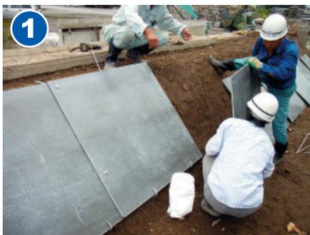
製品連結部分(製品裏面の丸孔側)に支承ゴムを貼り、左右の製品を10cm重ねて設置し(写真2参照)、下部はL字アンカー筋で、左右はボードファスナーで、天端は埋設プレートでそれぞれ固定します。
