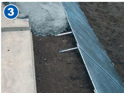
埋設プレートはボルトナットで製品本体に取付け、差筋で固定します。製品とコンクリートの間に隙間ができないように、棒パイプ等で入念に充填しながら路肩部に天端コンクリートを打設します。
