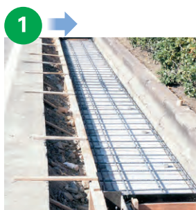
KCフォームの上に配筋した状態
