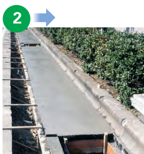
コンクリート打設
