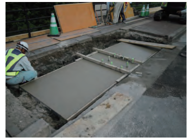
⑥仕上げ・養生
