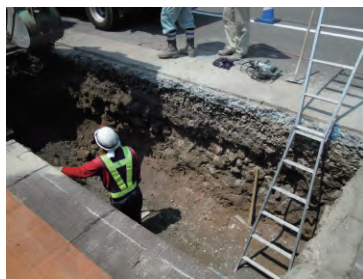
①掘削状況
