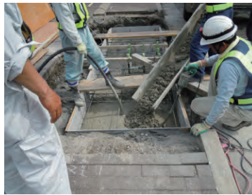
⑤生コン打設
