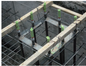
④アンカー筋設置
