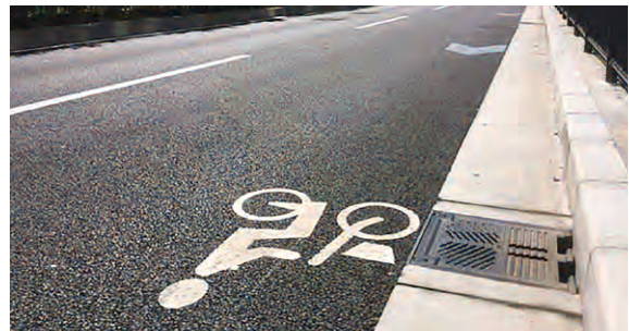
ヒノダクタイル鋳鉄製 落葉対策グレーチング 「GR-L」 NETIS登録:QS-140011-A
