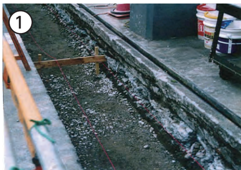
① 基礎砕石 敷設
