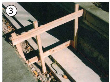
③ インバートコンクリート打設
