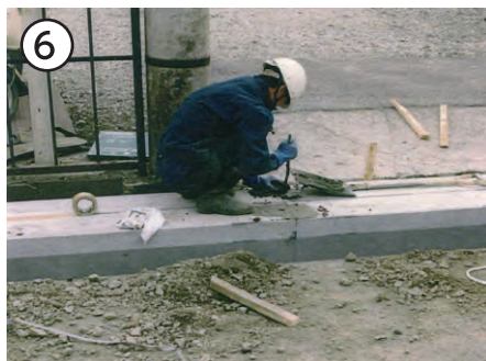
⑥ 縦目地の処理 → 完成
