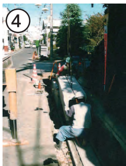
④ 製品据付け
