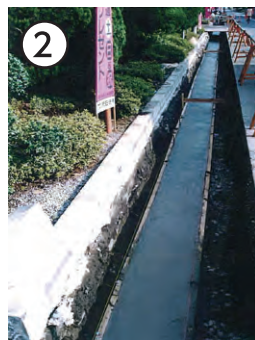
② ベースコンクリート打設
