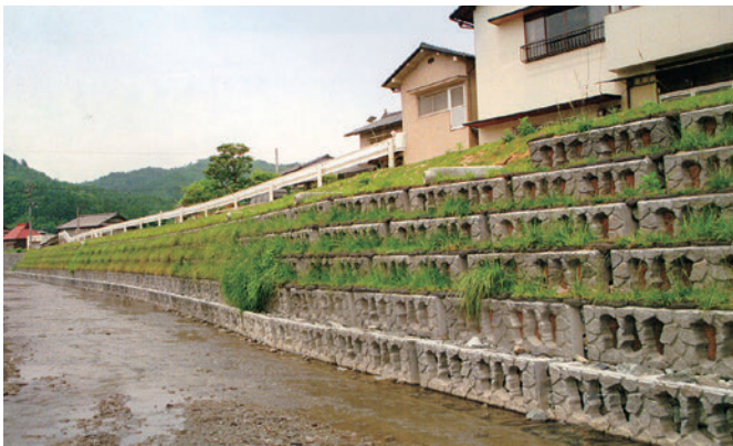
カゴボックス多段積みタイプ道路使用例
