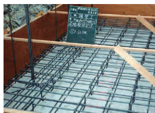
⑤ 縦貫コンクリート打設
