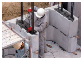
⑤ 縦貫コンクリート打設
