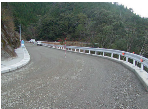
⑦完成直前天端部
