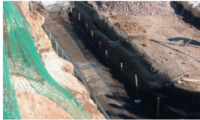
1.かごテンサー基礎敷設
