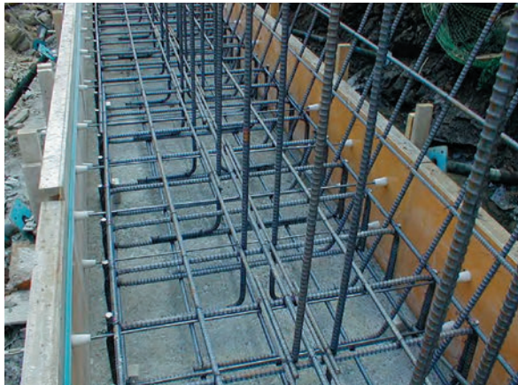
③底板部配筋
