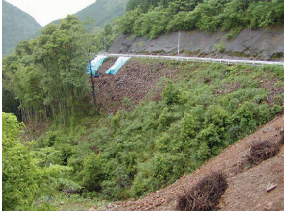
①工事着工前
