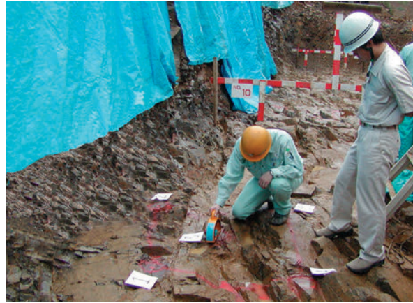
②地盤支持力確認
