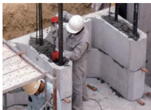
⑤ 縦貫コンクリート打設
