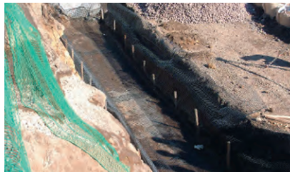
1.かごテンサー基礎敷設
