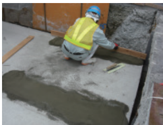
③ モルタル敷設
