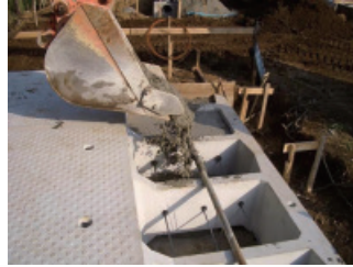
⑦ 間詰コンクリート打設
