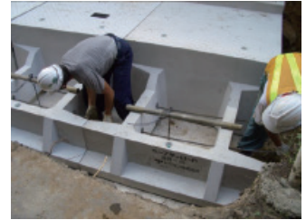
⑥ 鉄筋挿入
