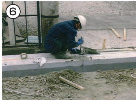
⑥ 縦目地の処理 → 完成
