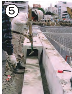
⑤ 内面のモルタル詰め ※据付けしたCドレーン内面との隙間は、 長い柄刷毛ほうきを用いて、空練り モルタルにより間詰めを行ってください。
