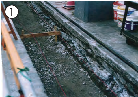
① 基礎碎石 敷設
