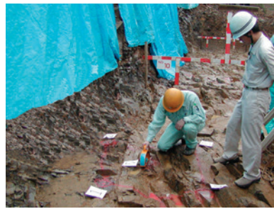
②地盤支持力確認
