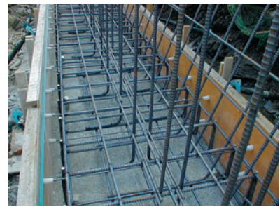
③底板部配筋
