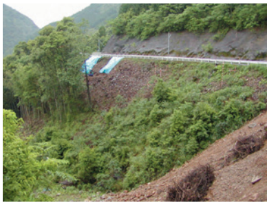
①工事着工前
