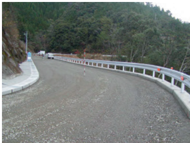
⑦完成直前天端部
