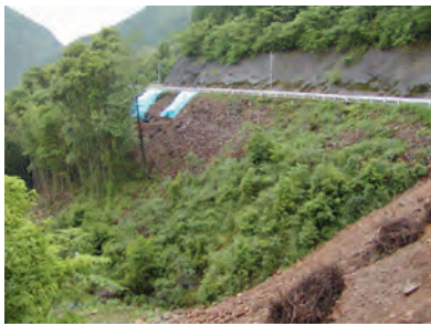
① 工事着工前
