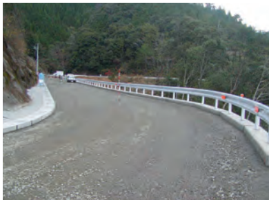
⑦ 完成直前天端部
