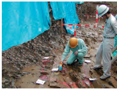
② 地盤支持力確認
