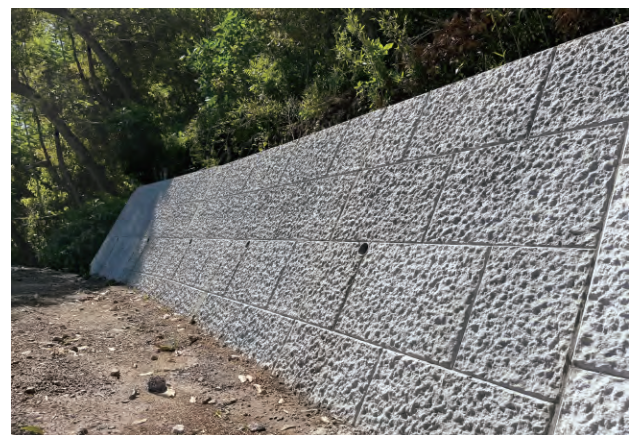
製品はイモ積みで施工しますが、千鳥積みのように見えるテクスチャーです。
