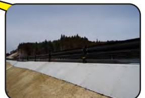
三陸沿岸道路 南三陸町
