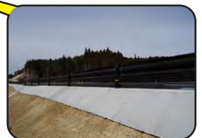
三陸沿岸道路 南三陸町
