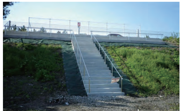
仙台東部道路のり面管理用通路設置工
