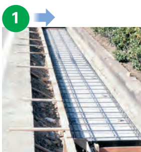
KCフォームの上に配筋した状態
