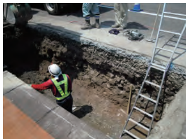
①掘削状況
