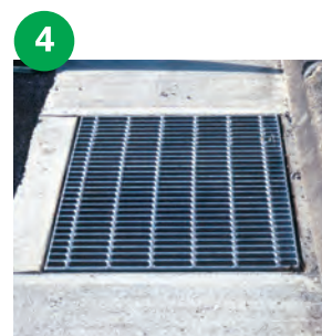
グレーチング設置
