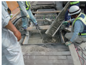
⑤生コン打設
