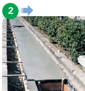
コンクリート打設
