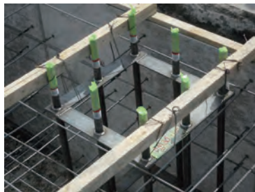
④アンカー筋設置
