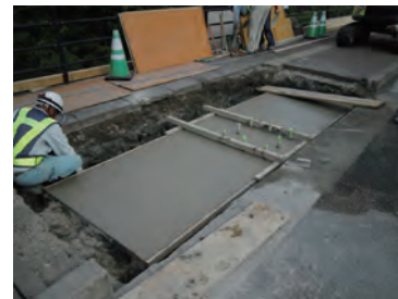
⑥仕上げ・養生
