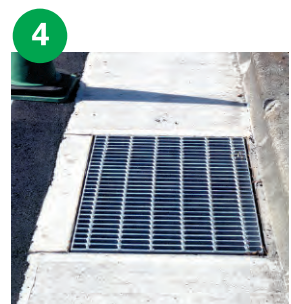
グレーチング設置
