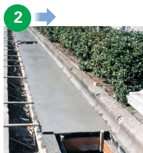
コンクリート打設
