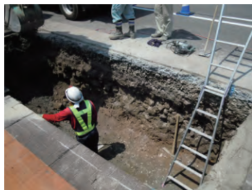
①掘削状況
