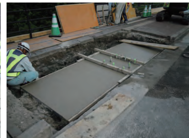
⑥仕上げ・養生
