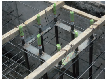
④アンカー筋設置
