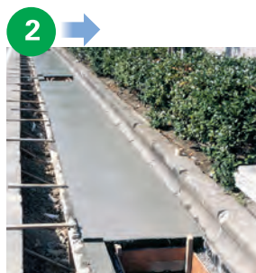
コンクリート打設
