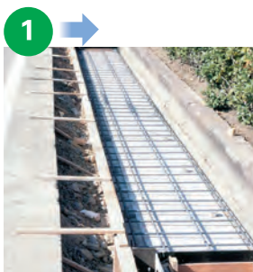
KCフォームの上に配筋した状態
