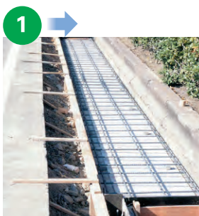
KCフォームの上に配筋した状態
