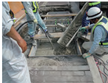
⑤生コン打設
