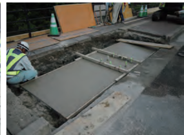
⑥仕上げ・養生
