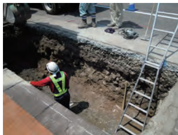
①掘削状況
