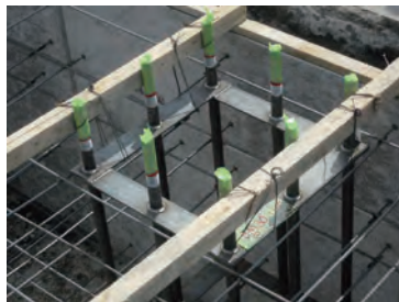
④アンカー筋設置
