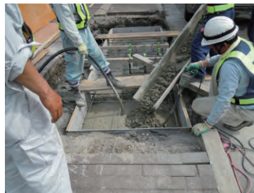
⑤生コン打設
