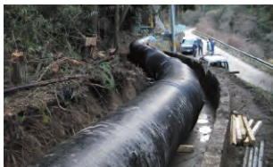
▲上水道管(誘導管)
