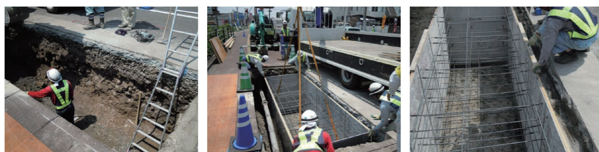
①掘削後敷砂
