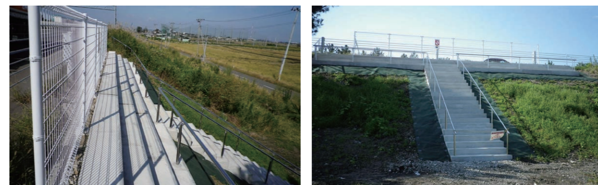
▲仙台東部道路のり面管理用通路設置工▲
