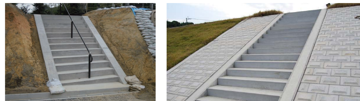
▲仙台東部道路のり面管理用通路設置工▲
