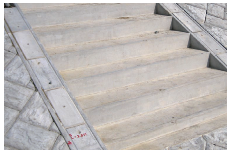
▲階段端部止工
