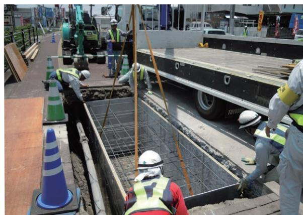
落橋防止装置の残存型枠として
