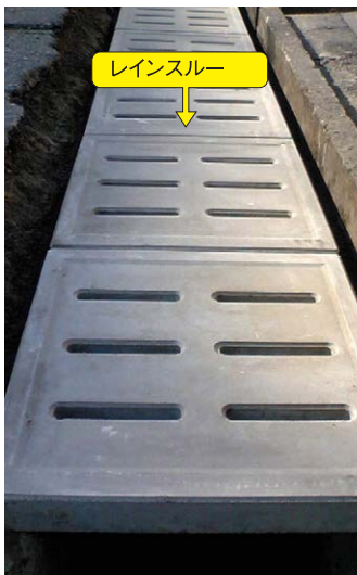
▼施工中(レインスルー敷設)
