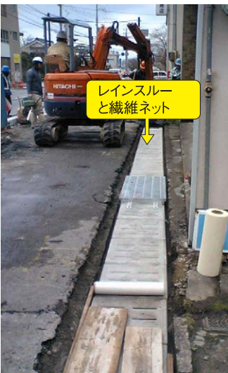
▼施工中(繊維ネット敷設)
