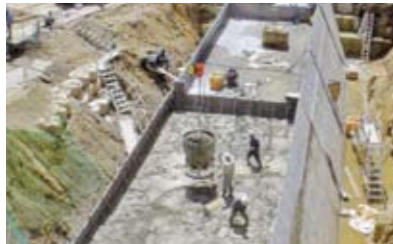
5.コンクリート打設状況
