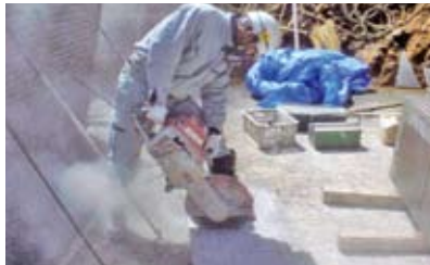
4.型枠パネル切断加工状況
