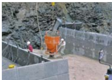
5.コンクリート打設状況
