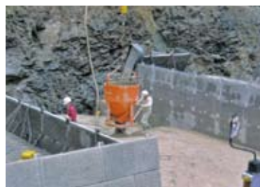
5.コンクリート打設状況
