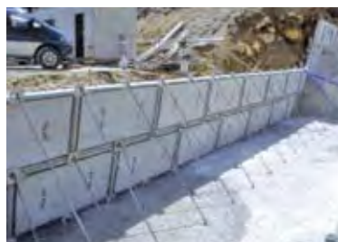
4.2段目設置完了状況
