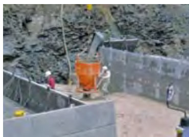
5.コンクリート打設状況
